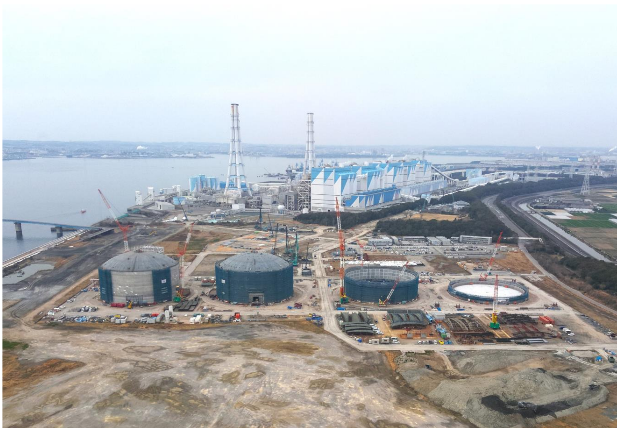
JERA 碧南火力発電所商用アンモニアタンク建設工場の様子 提供：JERA
