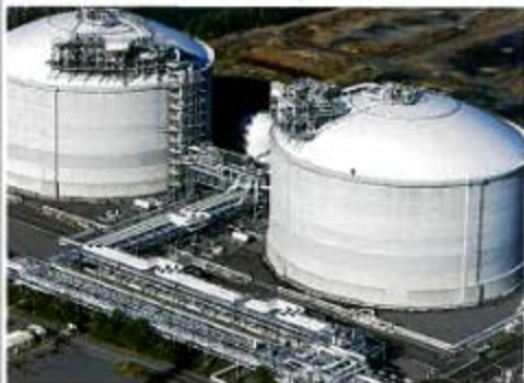
LNG pipe installation work
