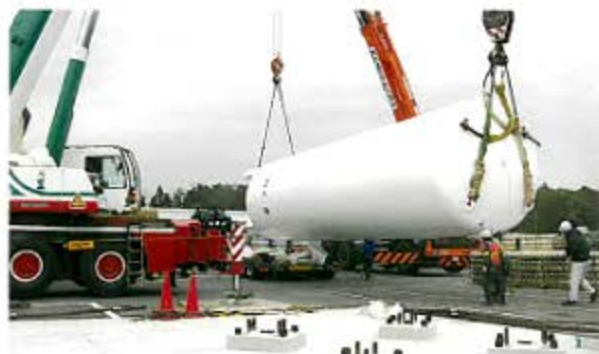
LNG satellite installation work
